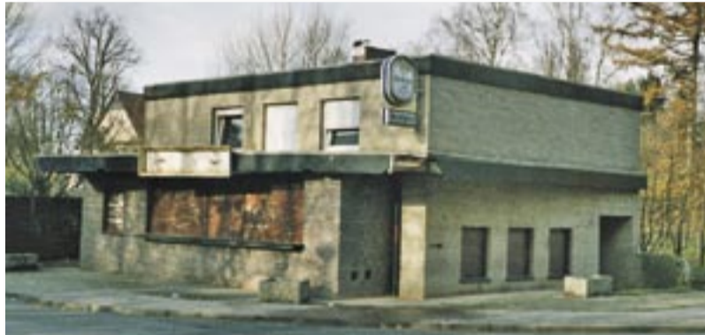
Der ehemalige Kiosk in der Straße „Am Wollepark“ wird abgerissen
