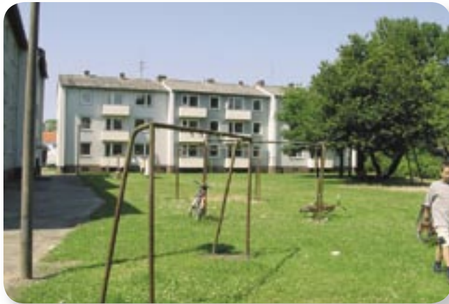
Die alten Wohnblöcke wurden im vergangenen Jahr abgerissen.
