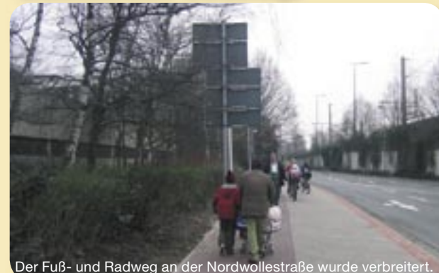
Der Fuß- und Radweg an der Nordwollestraße wurde verbreitert.
